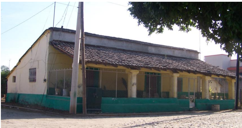
Fotografía 5. Vivienda con doble portal, uno al frente alineado a la calle, de convivencia social y el otro al interior, donde se desarrolla la interacción familiar. Fuente: Servando Rojo
