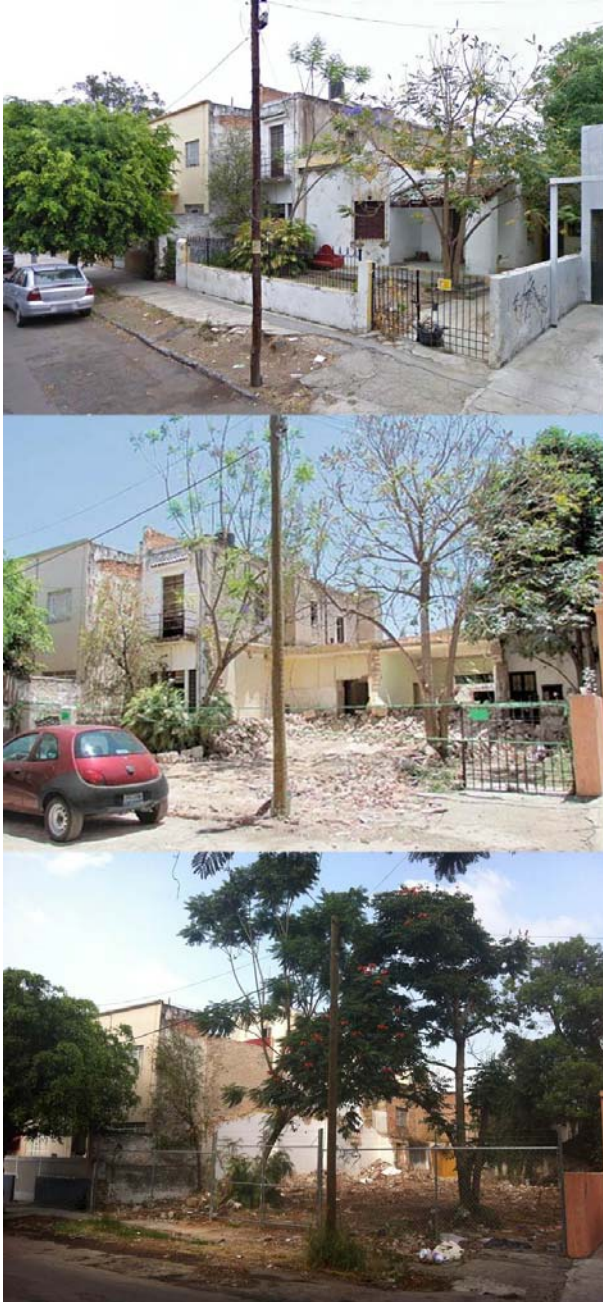
FINCA DEMOLIDA SIN AUTORIZACIÓN EN LA CALLE COLONIAS ENTRE GUADALUPE ZUNO Y EFRAIN GONZALEZ LUNA
