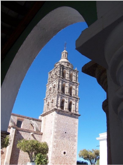
Fotografía 5. Detalles de la torre de la iglesia parroquial. Fuente: Servando Rojo
