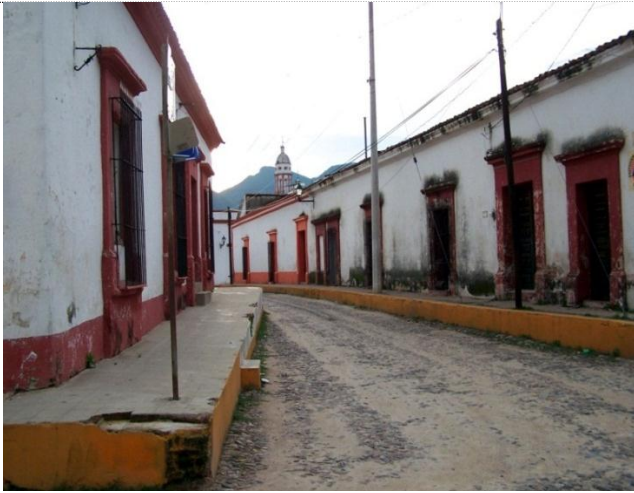
Fotografía 3. Calle típica de la ciudad de Cosalá en donde se observa la tipología arquitectónica predominante. Fuente: Servando Rojo
