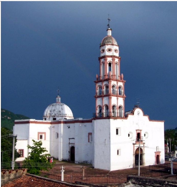
Fotografía 2. Iglesia Santa Úrsula, Cosalá. Fuente: Servando Rojo
