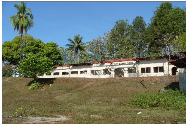
Foto 3. Hospital “Rehabilitación” en el campamento “Central” de la colonia penal de Coiba
