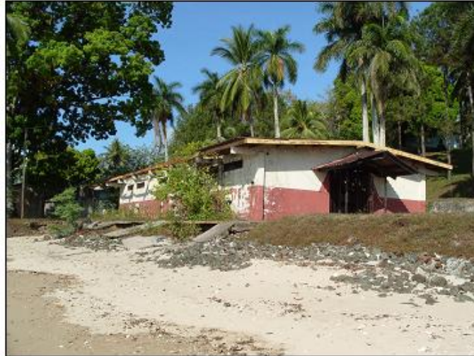
Foto 4. El edificio de la cárcel, ubicada en el campamento “Centro Penitenciario” de la colonia penal de Coiba
